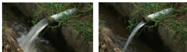
流量調整板取付前後の排水
