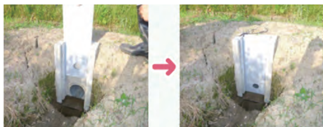
流量調整板（立板式）取付状況
